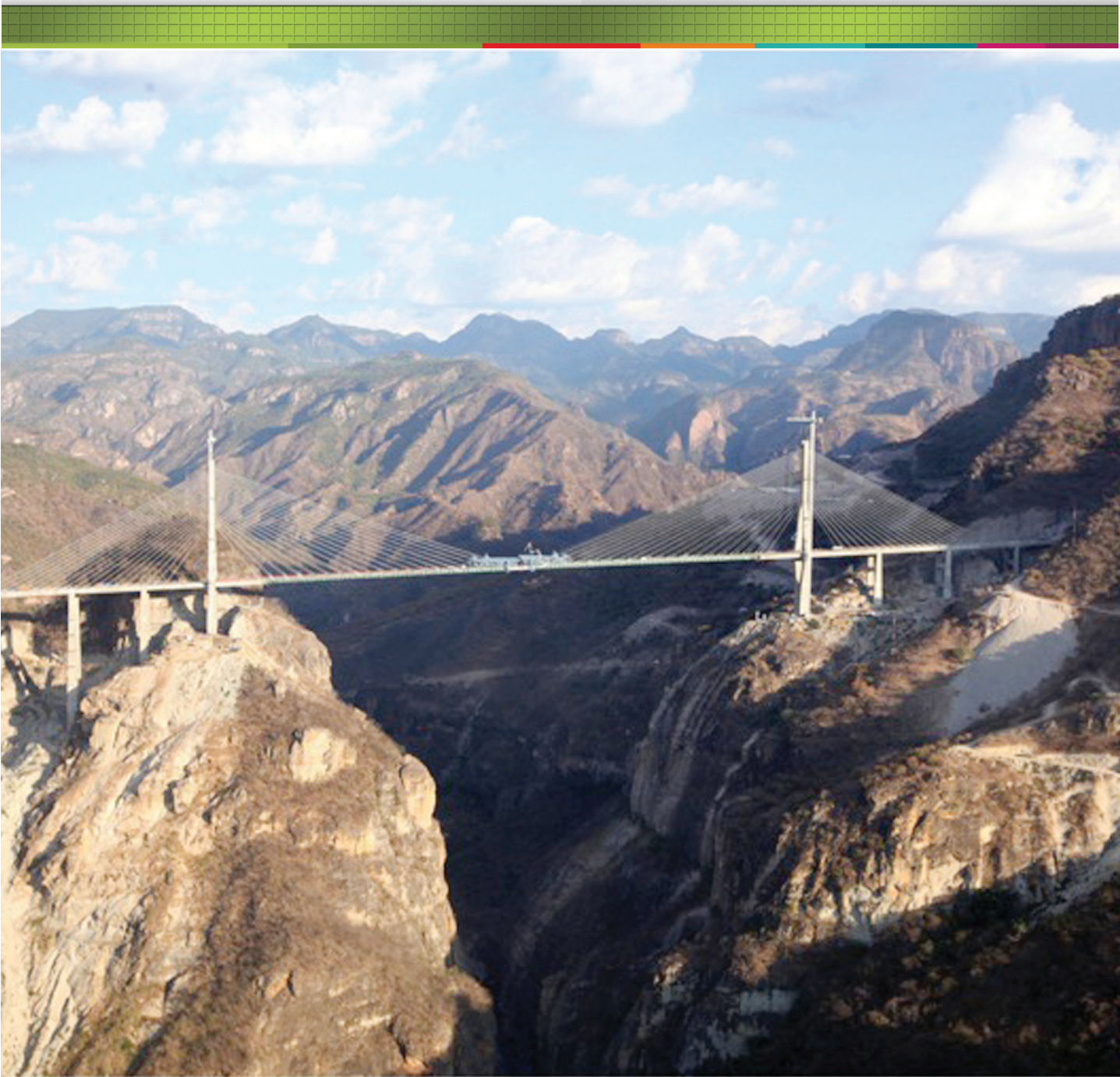
Puente “El Baluarte”
